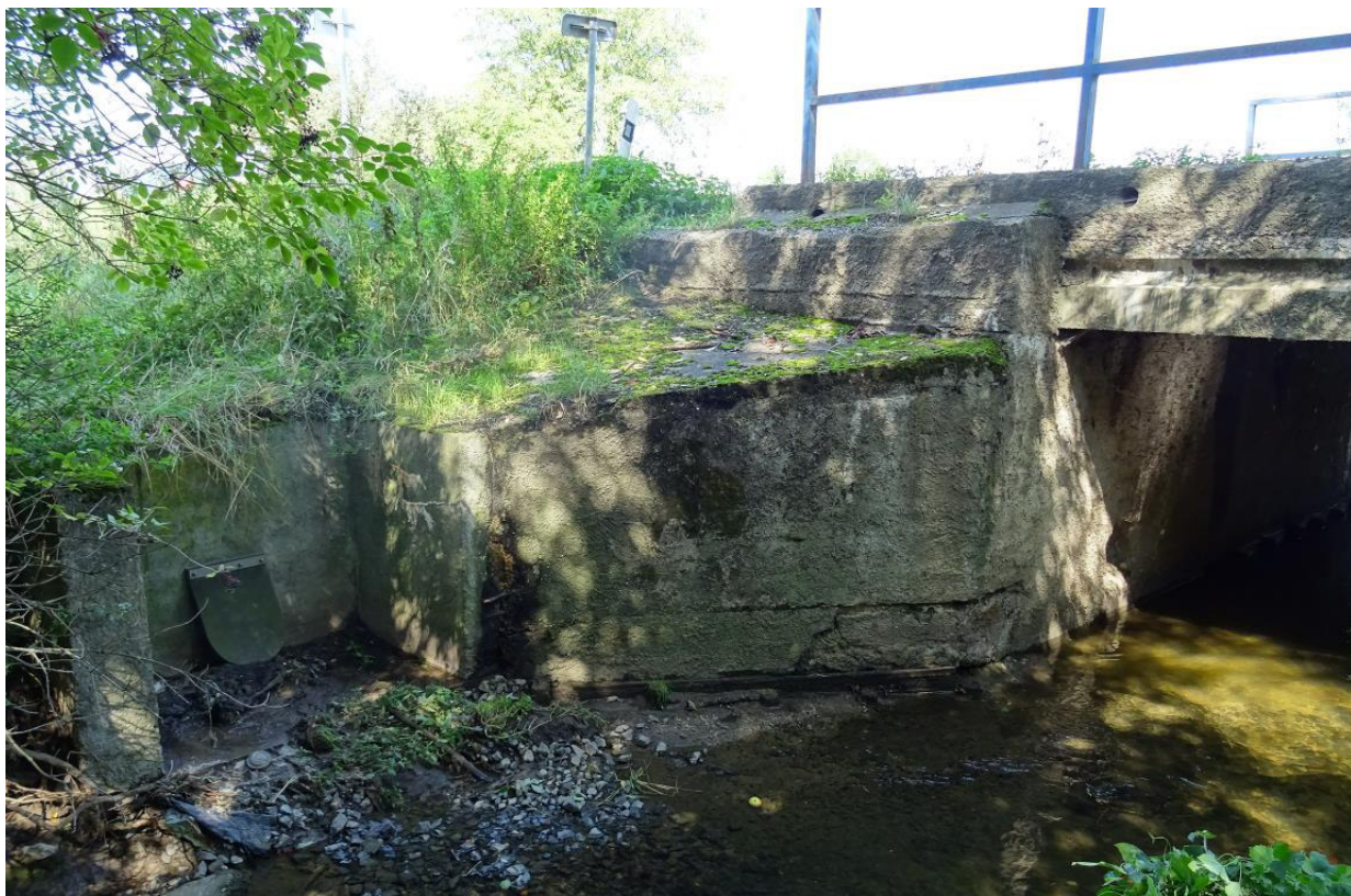
Obr. 3 Opěra 01 a pravé křídlo + výústní objekt kanalizace – návodní strana
