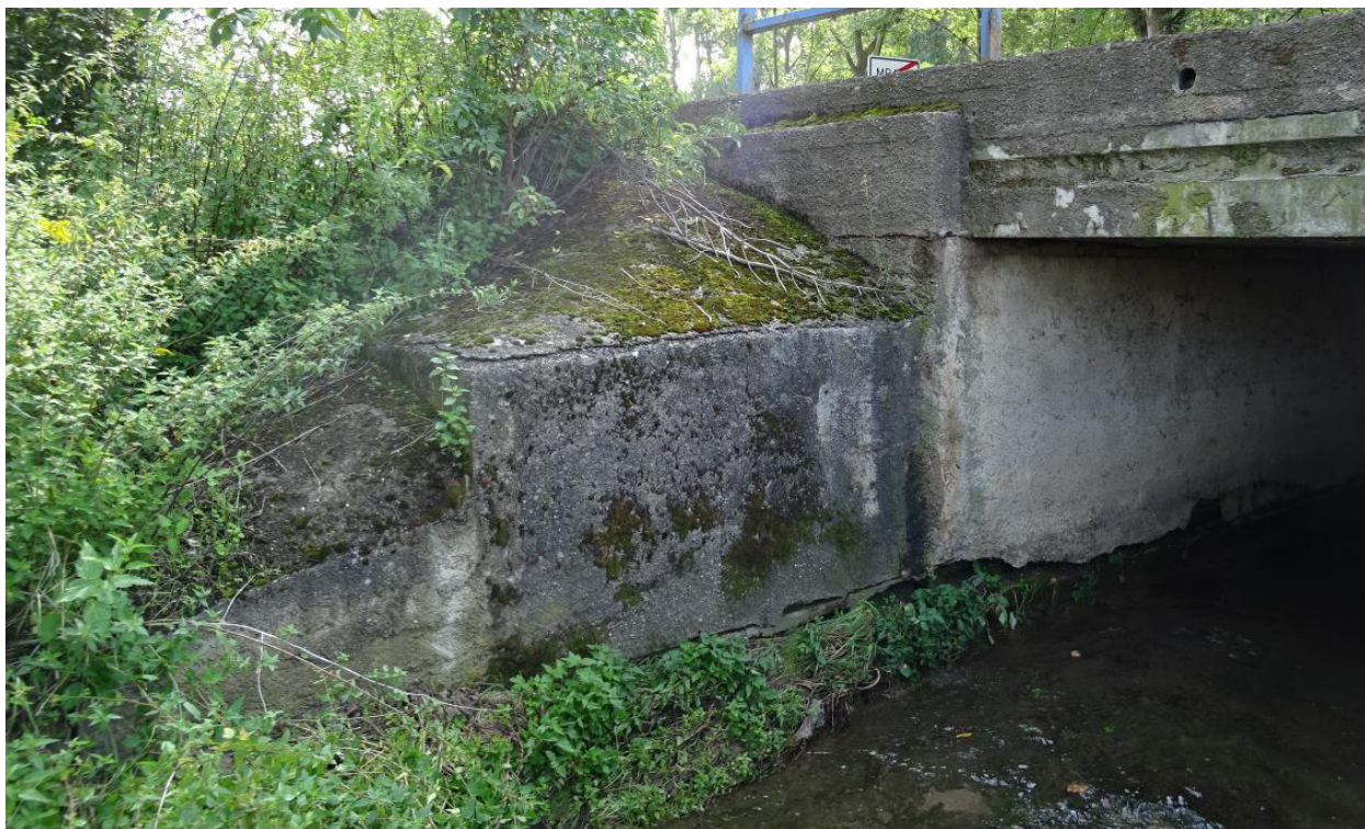
Obr. 6 Opěra 02 a levé křídlo – povodní strana
